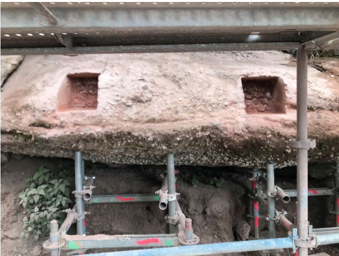
Renforcement du rocher par incorporation de tirants (travaux sous-traités à la société ROC Aménagement)
