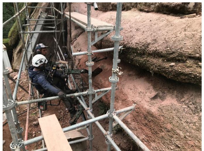
Renforcement du rocher par incorporation de tirants (travaux sous-traités à la société ROC Aménagement)
