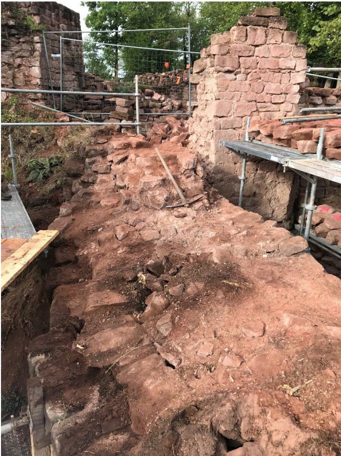
Renforcement du rocher par incorporation de tirants (travaux sous-traités à la société ROC Aménagement)
