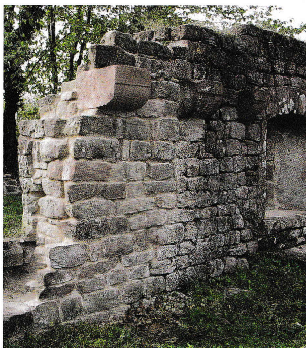
Fig. 13 et 14 Grand-Geroldseck - Mur sud du bâtiment B14 avant et après consolidation (Photos Bernard Haegel)
