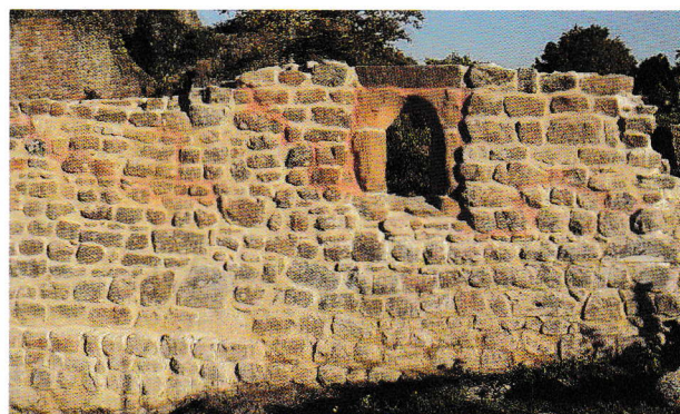
Fig. 11 Girbaden - Fenêtre des commons après consolidation (Photo Françoise SIEFFERT)
