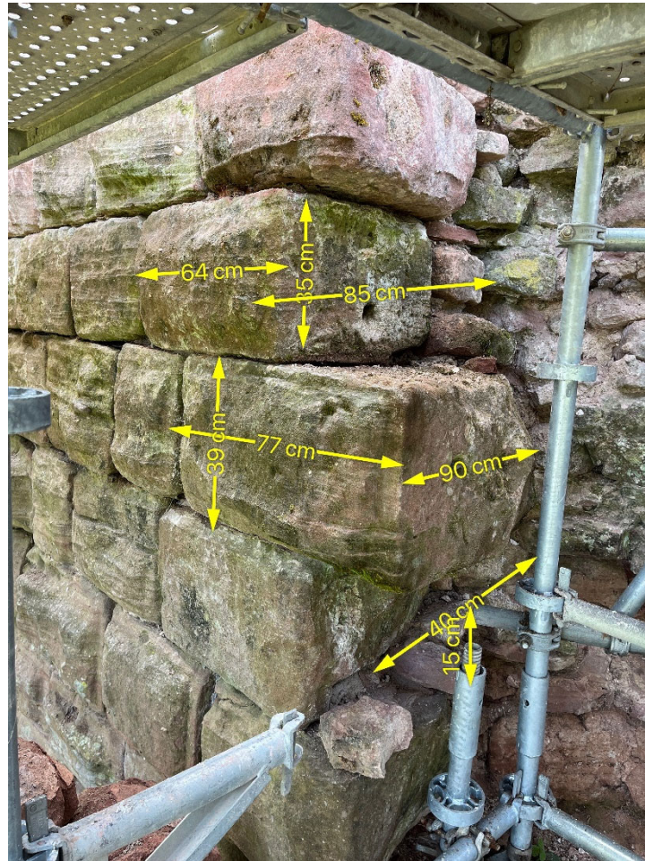
Zone N3 – En-dessous, dépose/repose de deux pierres instables en partie haute
