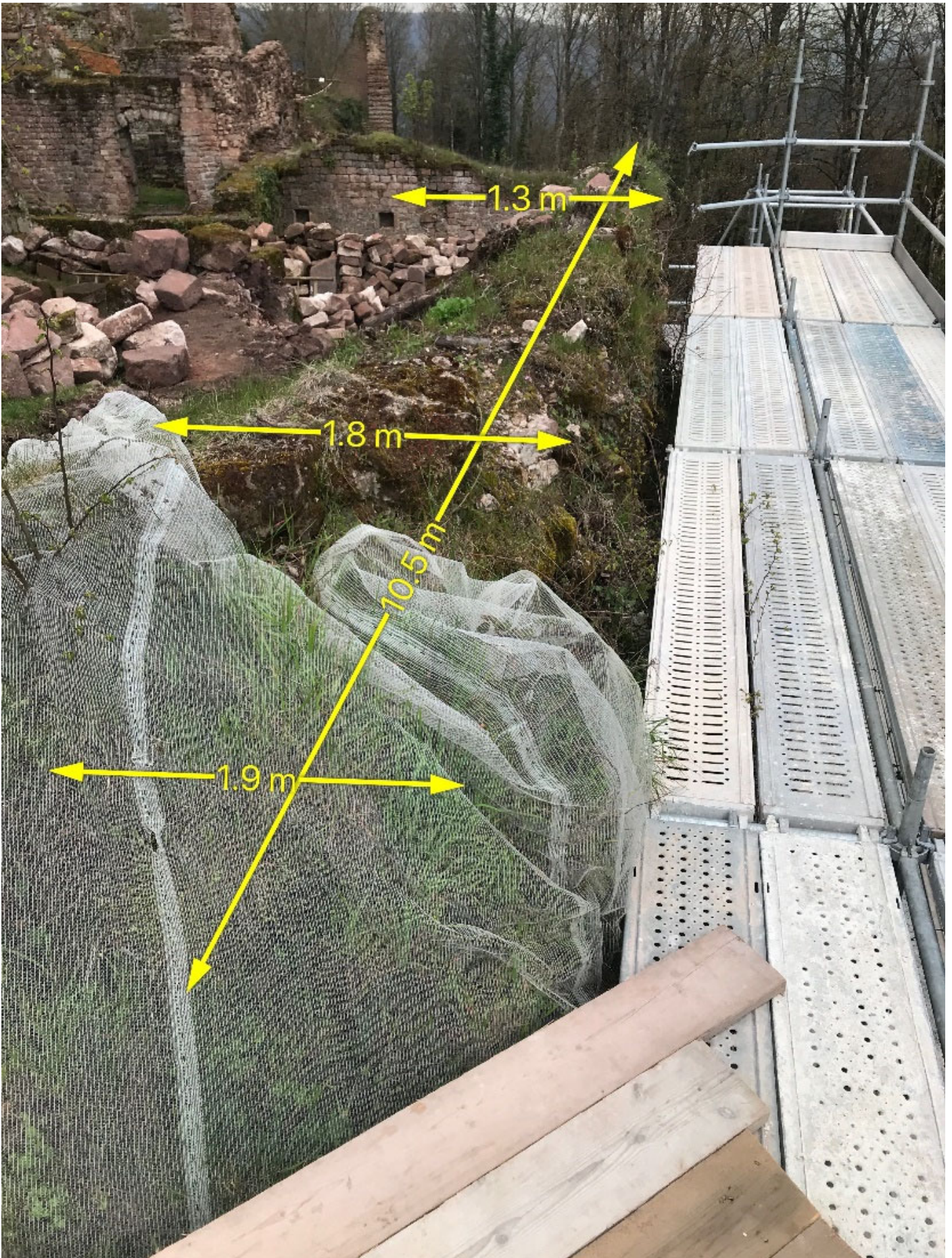
Zone N – sommet du mur – Après dévégétalisation, purge du blocage
