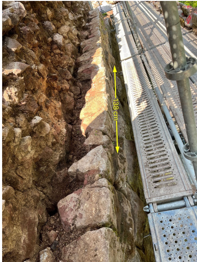
Zone N2 – réalignement de 5 pierres par dépose/repose
