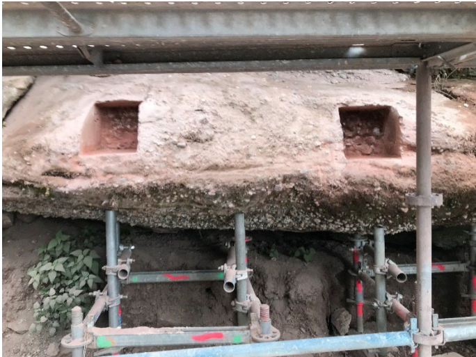
Photo n°1 : taille des chambres de forage
