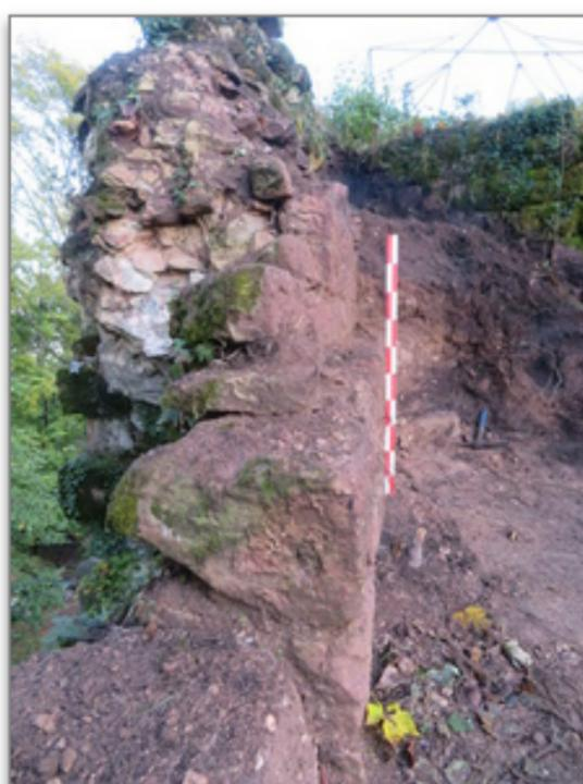
Le parement intérieur du mur d'enceinte contre lequel reposait le talus comporte un décrochement d'une largeur de 20cm.
