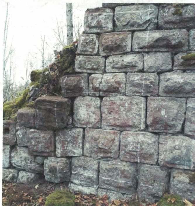
Nideck : arrachement de mur en péril, suite à la croissance d'un arbre derrière le parement. Une quinzaine de blocs sont ici à déposer et reposer pour cicatriser ce mur.
