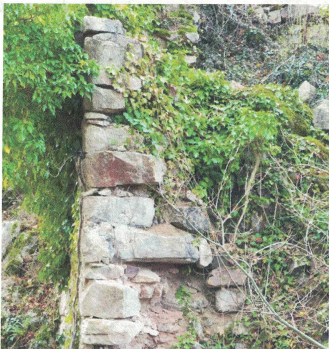
Arrachement dangereux au Landsberg Coupe sur arrachement montrant le blocage altéré et même absent
