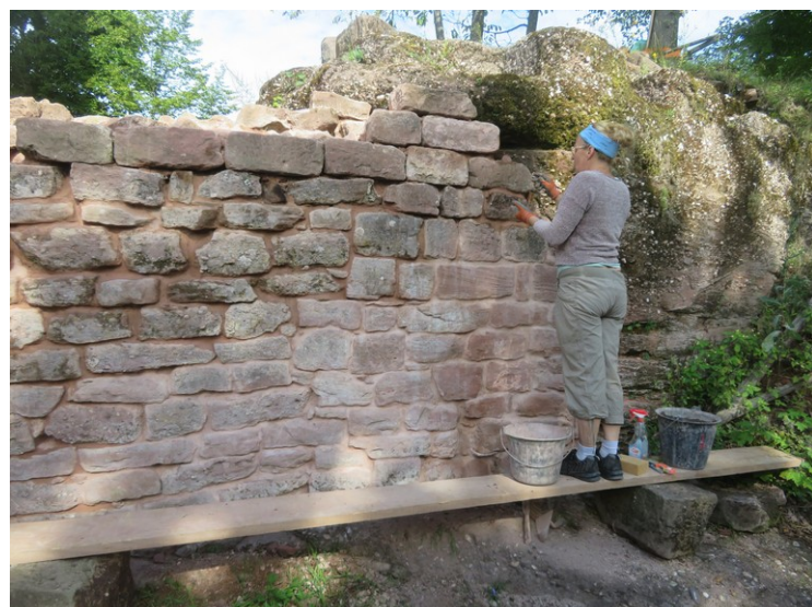
Jointoiment face Est
