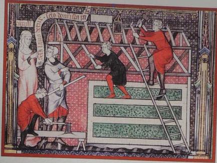
Les charpentiers réalisent les ouvrages en bois du château : charpentes, galeries, portes, cintres... ainsi que les deux types d'**échafaudages** nécessaires à la construction :
