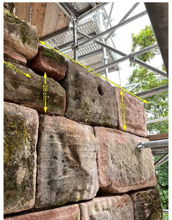
Mur O1 – Restitution de la maçonnerie manquante et détail contre le rocher à gauche (partie basse)
