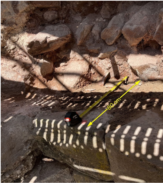
Mur O1 – ci-dessus pierre d'angle assise 14 Mur O1 – ci-contre profondeur de la maçonnerie assise 10 à gauche contre le rocher
