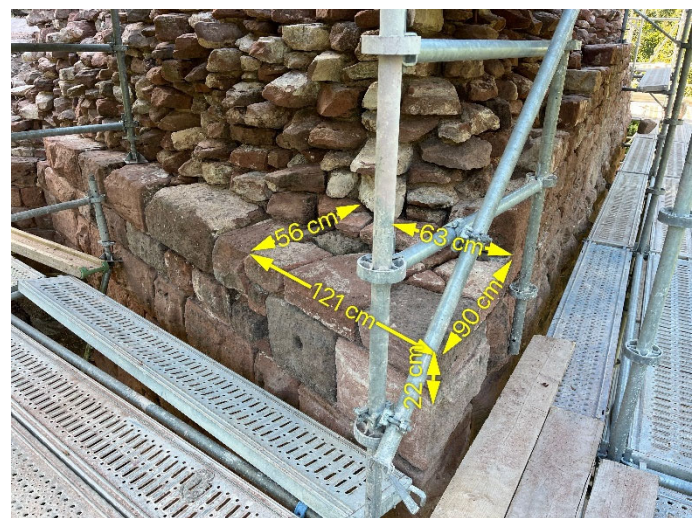
Tout à la fin des travaux, rajout de quelques moellons de parement pour rattraper la différence de niveau au droit de l'angle O1/N1
