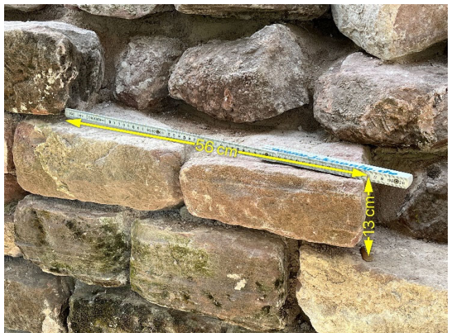
Mur N2 – Montage de la partie haute du parement (préalablement déposée, mais remontage différent)
