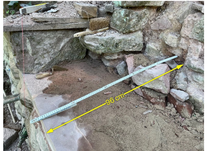
Mur N3 – épaisseur du mur à divers endroits (photo page précédente, photos ci-contre et ci-dessus)
