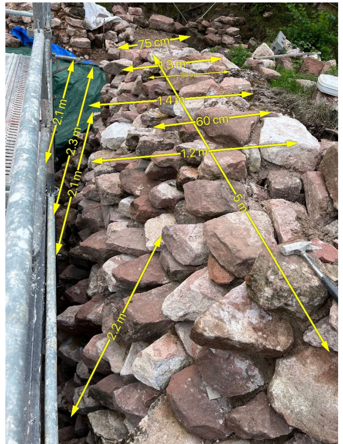
Mur O1/O2 – Au-dessus du parement – purge du blocage sur une profondeur ~20 cm avant remontage de la maçonnerie et réalisation de l'arrachement
