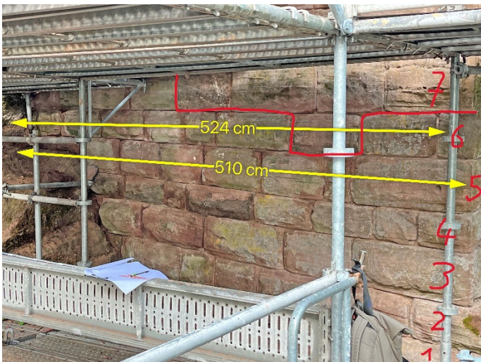
Mur O1 – Restitution de la maçonnerie manquante et détail contre le rocher à gauche (partie basse)
