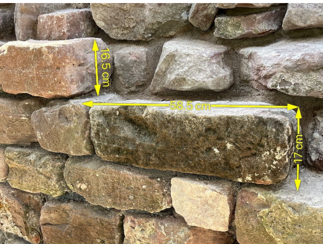
Mur N2 – Montage de la partie haute du parement (préalablement déposée, mais remontage différent)
