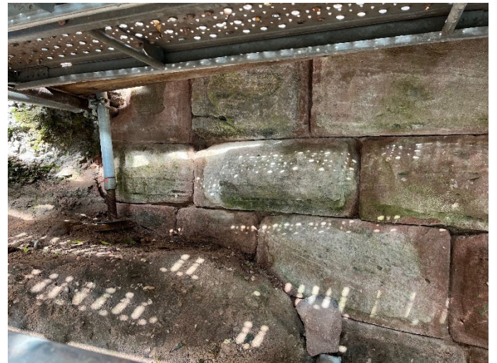
Mur O1 – Restitution de la maçonnerie manquante et détail contre le rocher à gauche (partie basse)
