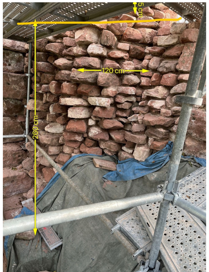
Mur N3 - Colonne de maçonnerie de blocage – reprise en sous-œuvre sous le blocage suspendu conservé
