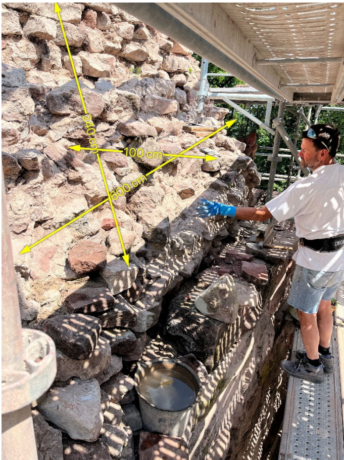
Mur O1/O2 – Au-dessus du parement – purge du blocage sur une profondeur ~20 cm avant remontage de la maçonnerie et réalisation de l'arrachement
