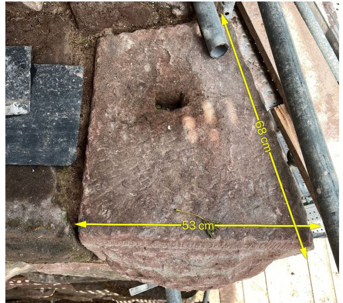
Mur O1 – ci-dessus pierre d'angle assise 14 Mur O1 – ci-contre profondeur de la maçonnerie assise 10 à gauche contre le rocher
