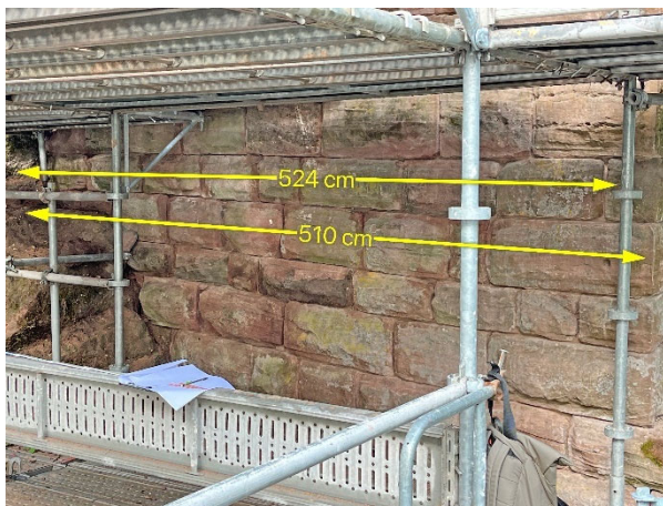
Base du mur O1 – Dépose/repose de 4 pierres de parement – assise 1 et 2
