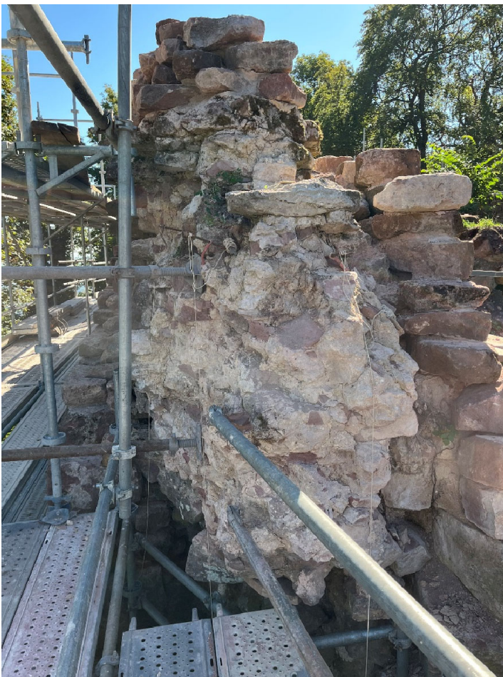
Mur N3 - Colonne de maçonnerie de blocage – reprise en sous-œuvre sous le blocage suspendu conservé
