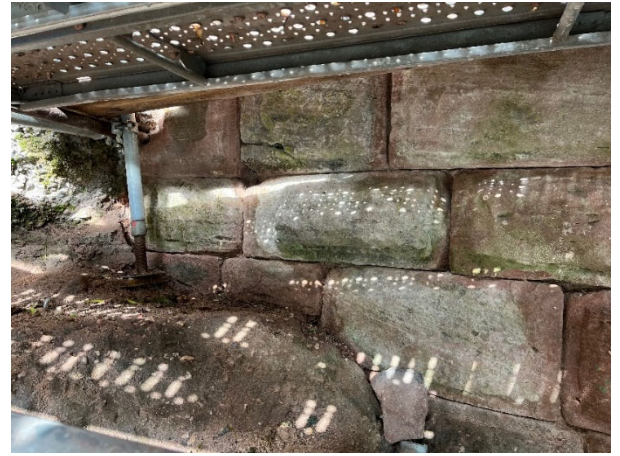
Mur O1 – Dépose/repose de la partie basse et détail de la partie maçonnée sur le rocher
