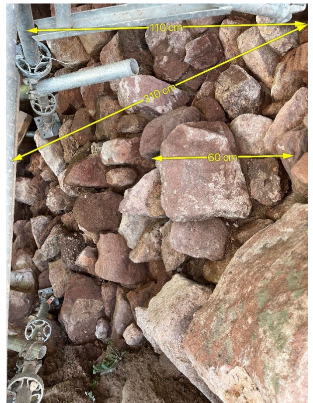
Mur N 3 – Maçonnerie de blocage à droite du parement rajouté, en pied de mur (vue de face et de dessus)
