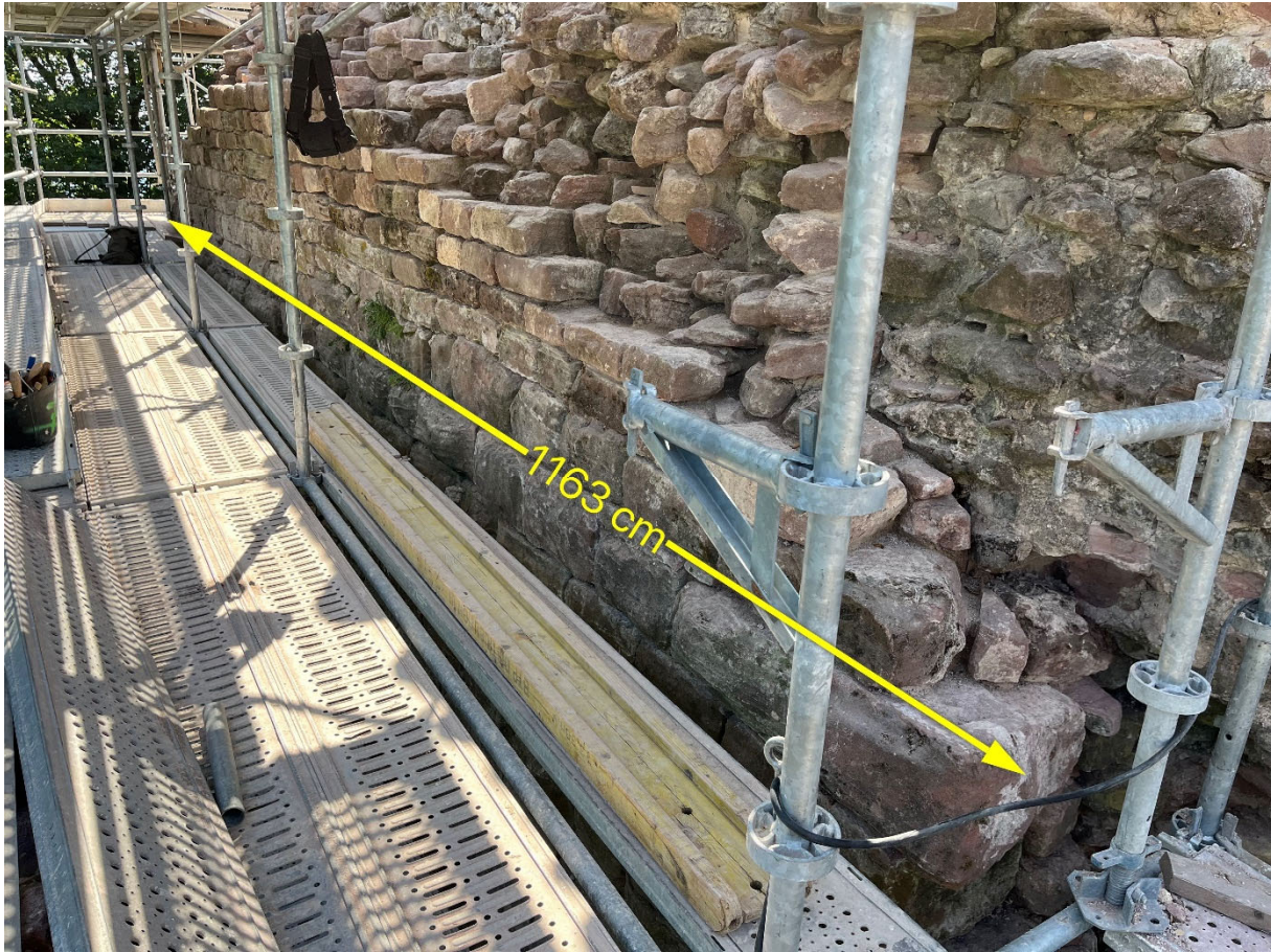
Longueur totale du mur N
