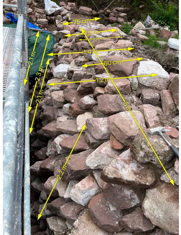
Mur O1/O2 – à gauche, maçonnerie de blocage en cours de remontage – à droite, arrachement
