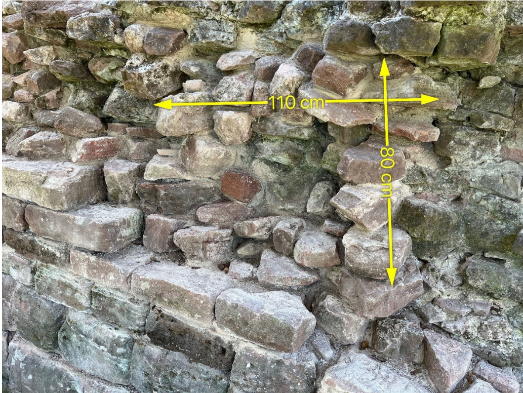
...rejointoiement sur arrachement existant au-dessus avec inclusions neuves
