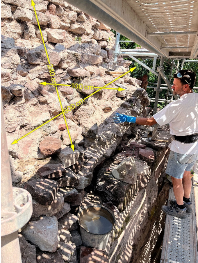
Mur O1/O2 – à gauche, maçonnerie de blocage en cours de remontage – à droite, arrachement
