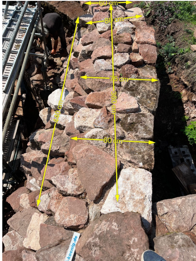
Mur O1 – Rocaillage au sommet
