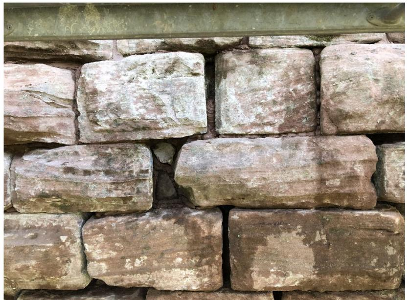
Rejointoiement en cours (joints non encore brossés) – remplissage des trous par relancis de moellons de blocage
