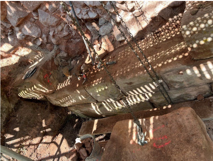
Remontage des maçonneries
